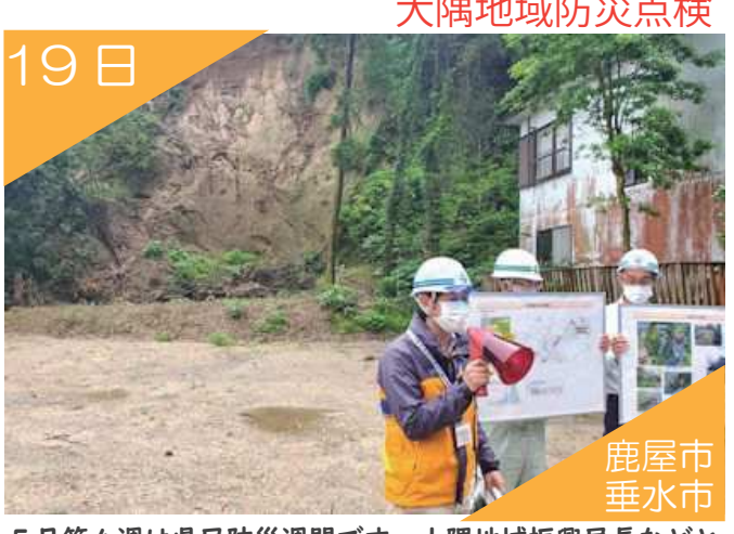
19日 鹿屋市 垂水市 5月第4週は県民防災週間です。大隅地域振興局長などと一緒に、鹿屋・垂水の点検箇所を巡らせて頂きました。
